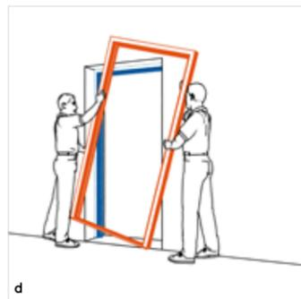
d Der neue Blendrahmen wird einfach übergeschoben und mit dem alten Rahmen verschraubt.
